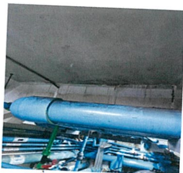
จุดที่ 16 แนวคานกลางเหนือท่อ
