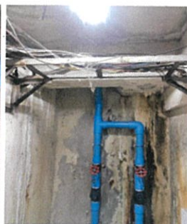
จุดที่ 2 แนวท่อน้ำดื่มและท่อ PVC
