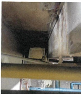
จุดที่ 5 แนวท่อน้ำดื่มในห้องไฟ
